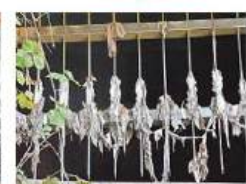
Der Regenentlastungskanal vor der Säuberung.
